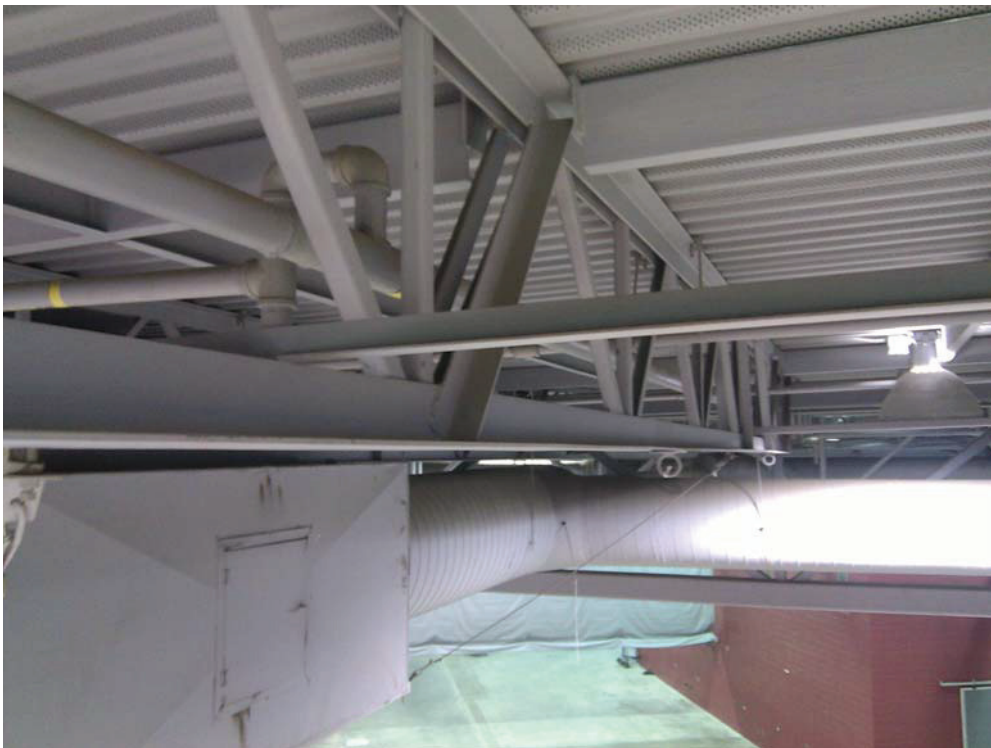
Photo #2 : Vue d'une poutrelle de la partie existante, avec ses points d'ancrage
