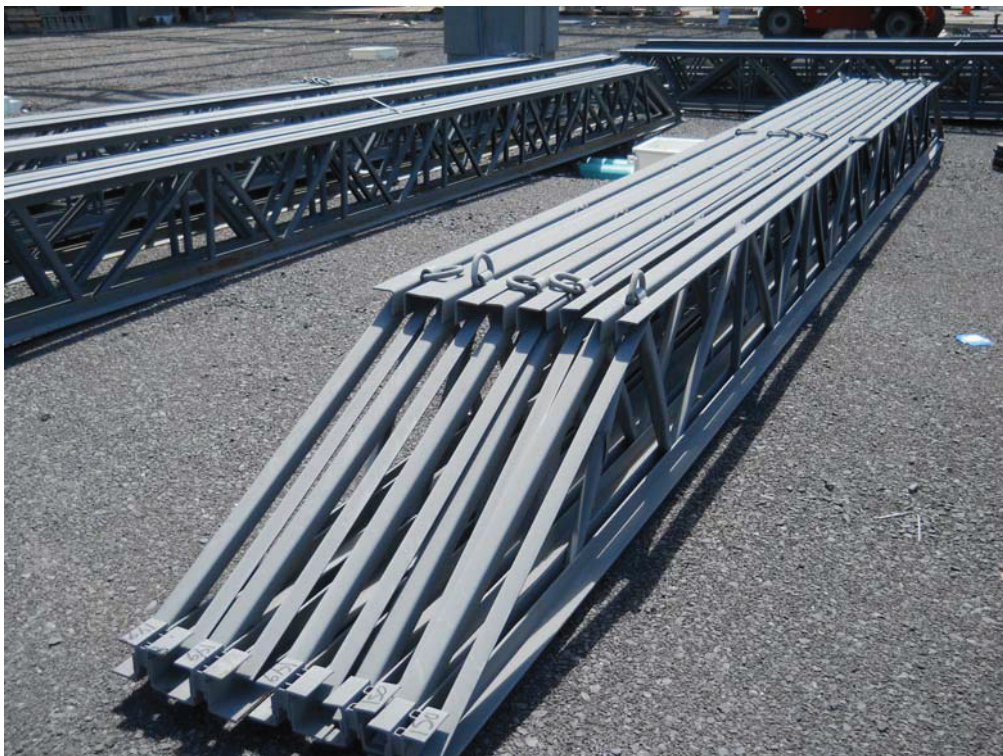
Photo #4 : Poutrelles de la nouvelle partie, avec points d'ancrage
