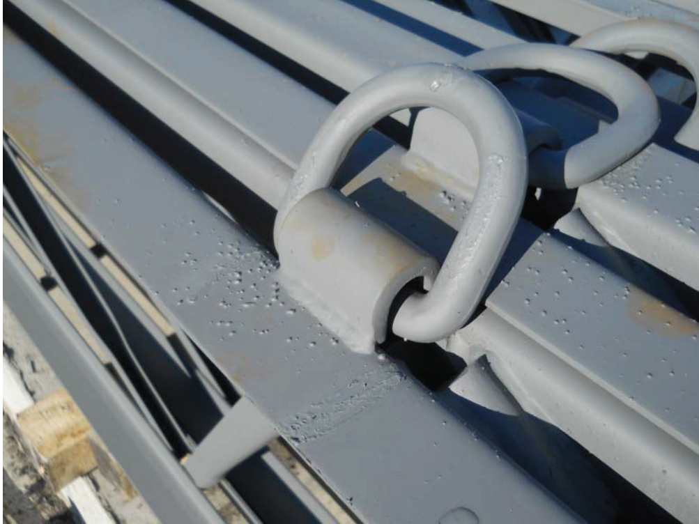
Photo #3 : Assemblage d'un anneau dans la nouvelle partie (2011)
