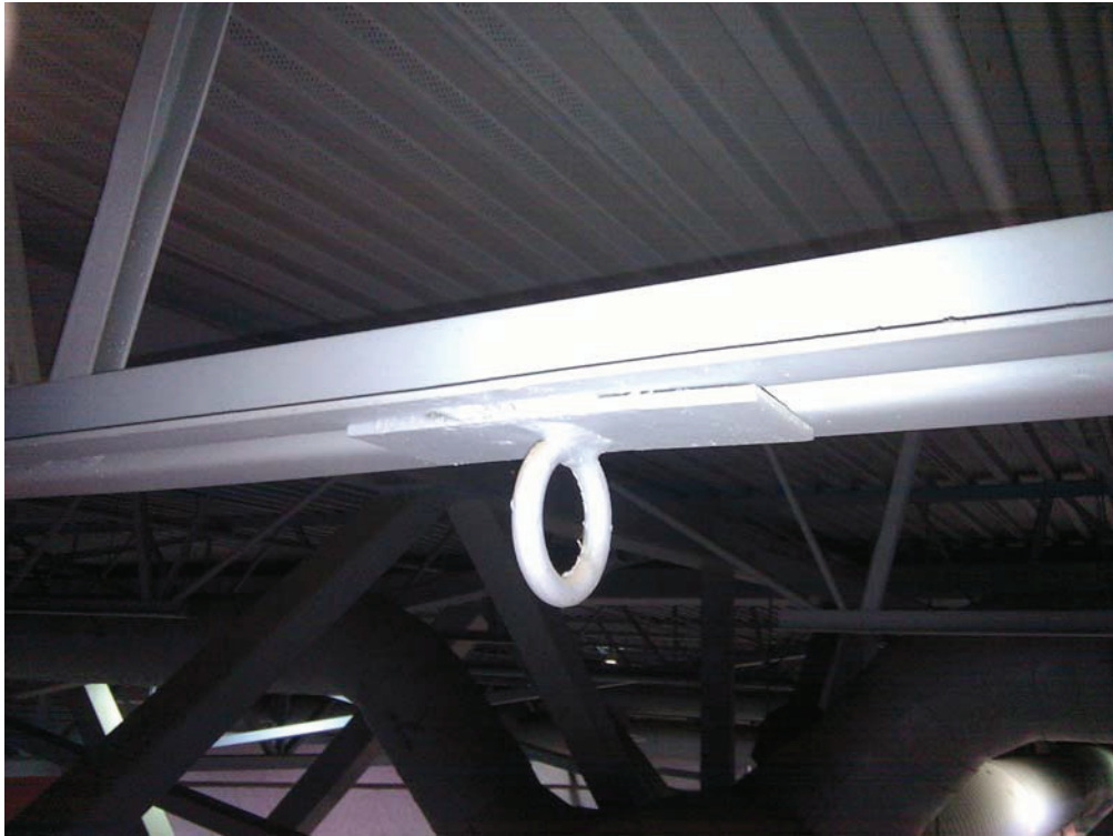
Photo #1 : Assemblage d'un anneau dans la partie existante (1996)
